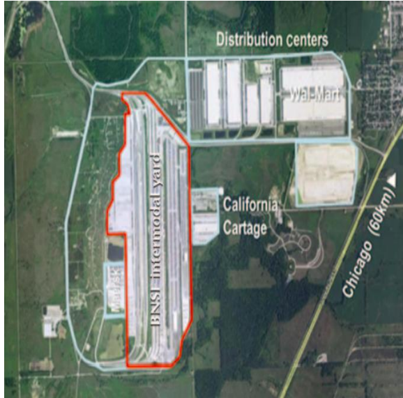
Figure 7. Centerpoint Intermodal Center (Luis C. Blancas, 2014)
